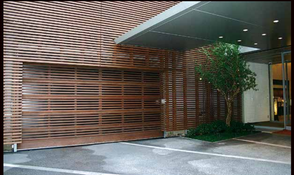
ガレージ内が見えないように、裏面全面に不透明のポリカを貼っています。 米松 色:キシラデコール ウォールナット OP:ポリカ貼り W4700×H2365
