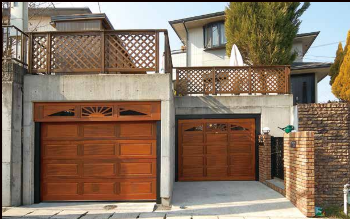
お施主様のご意向で手前はオーバースライダー、奥はスイングアップドアとなっています。 米桐 色:シッケンズ セトールHLS ウォールナット OP:明り窓 W2500×H1700 (左) W2500×H2100 (右)
