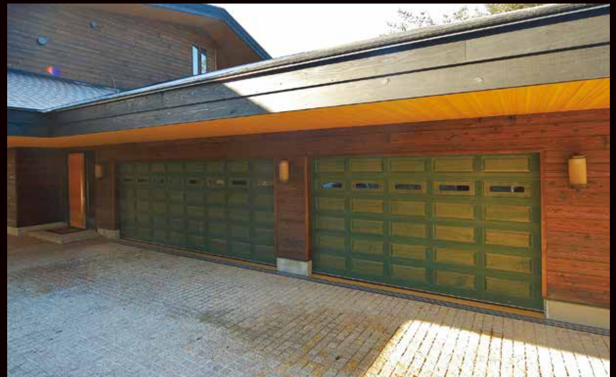
某企業様の保養所です。景観への配慮からガレージドアもグリーンとなりました。 米桐 色:ノンロット ZS-GG グラスグリーン OP:明り窓 W5260×H2120
