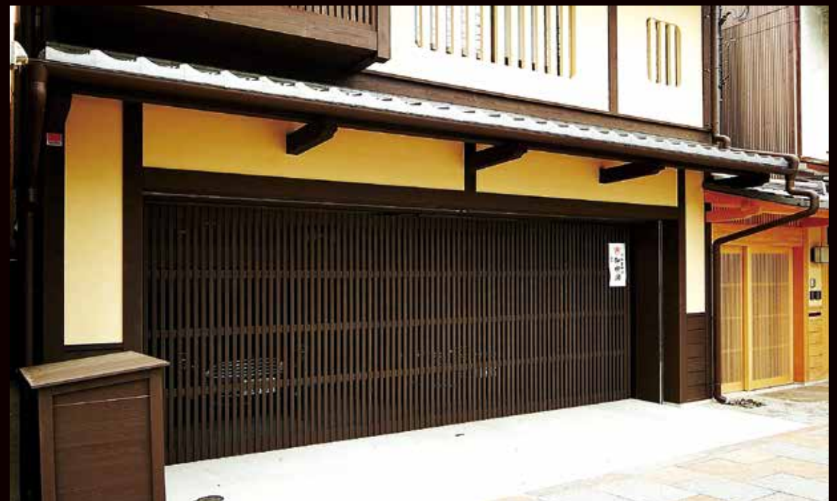
京都の景観保護地区条例により、格子指定があり納めた大手ゼネコン物件です。 一枚もののスイングアップドアで、塗装は建物と同じ「ベンガラ」※です。
