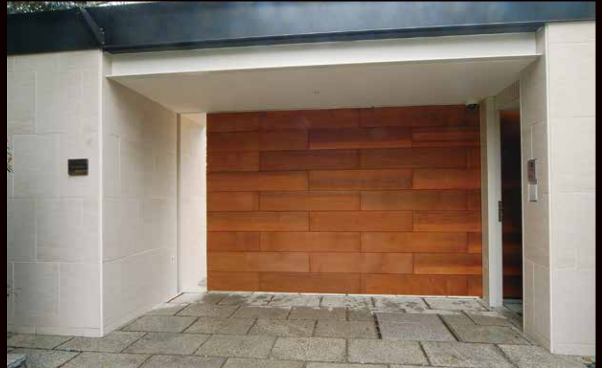
1枚ドアでサイドに引き込むタイプです。下レール無しで開閉します。 米杉 色:シッケンズ セトールHLS ダークオーク W3860×H2430
