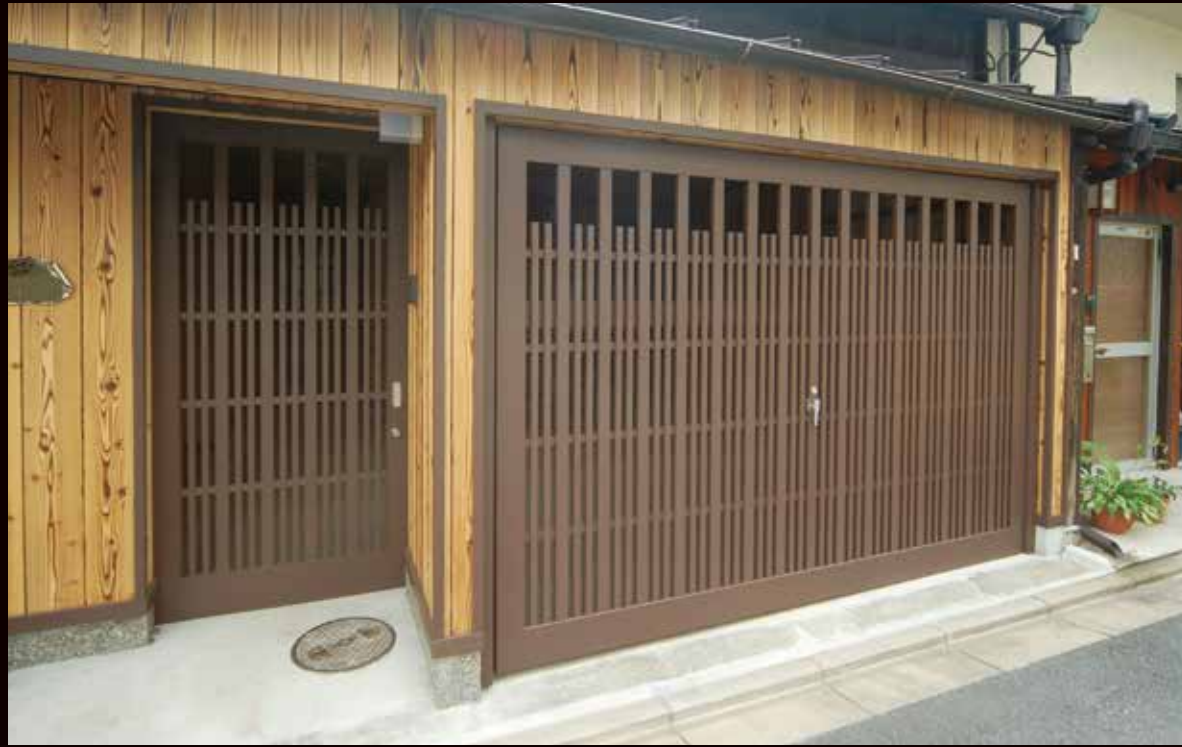
スイングドア手動式。玄関ドアとデザインを統一しています。 米杉 色：キシラデコール カスタニ W3000×H2100
