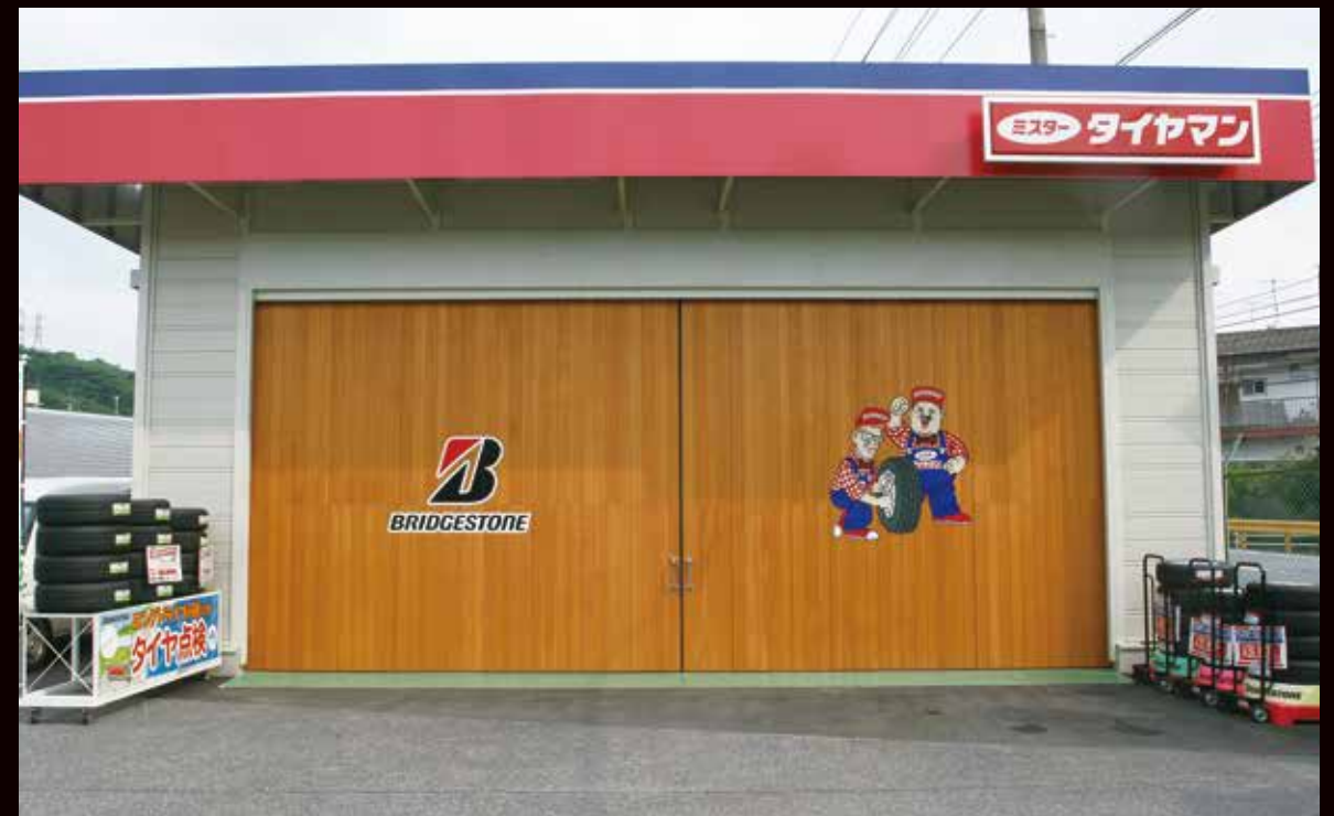
自動車修理工場。特大手動式サイドスライダーです。 米柵 色:シッケンズ ライトオーク W8000×H3500
