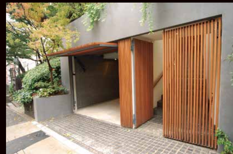
ガレージドアと玄関ドアが閉まった時に壁と一体になるデザインです。 米杉 色:シッケンズ セトルHLS ライトオーク スイングドア W3000×H2500 玄関ドアW2000×H2200
