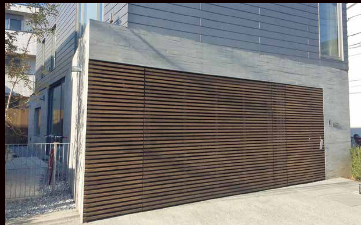
格子 面—スイングドアと開き戸。全面フラットに見えるように設置しました。 米松 色:キシラデコール ウォルナット W3400×H2200
