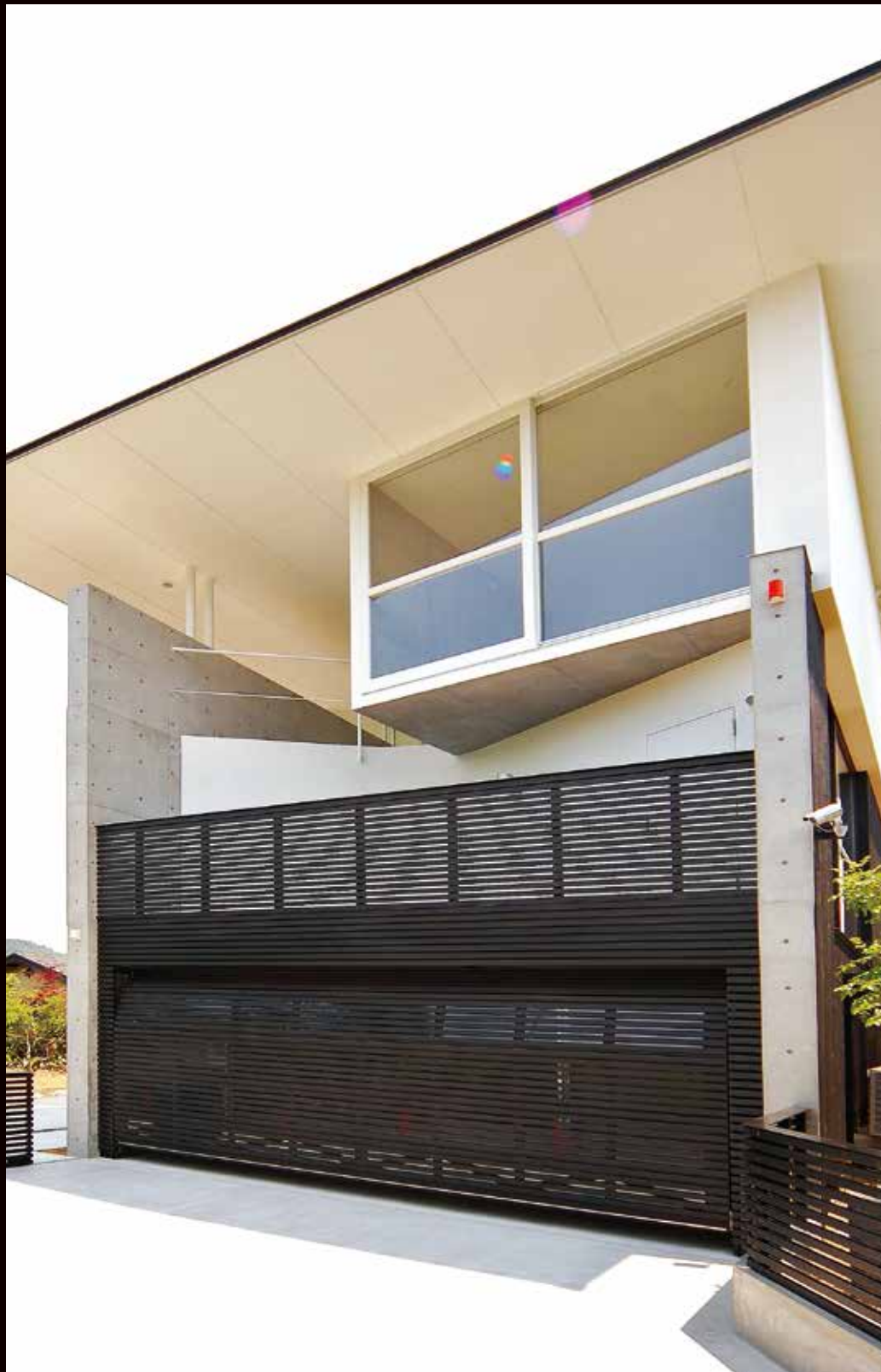
設計士の意向で、ベランダの手すりとガレージドアが一体に見えるデザインになっています。 米松 色:キシラデコール ジェットブラック W4850×H2125
