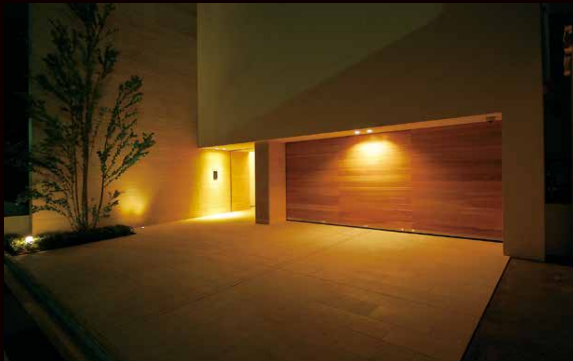
檜（ナラ）を使用しています。木目が美しく、室内の壁や床、建具などあらゆる場所に使われる高級材です。他にウォルナット、マホガニー、アッシュ等さまざまな樹種に対応いたします。 檜 色:シッケンズ セトルHLS クリアー W5260×H2200
